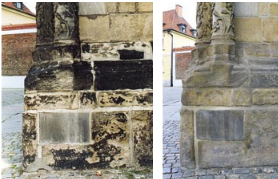
Fot. 11.2 Porównanie piaskowców pokrytych patyną i ulegających eksfoliacji, z tymi samymi ale po oczyszczeniu i renowacji.
