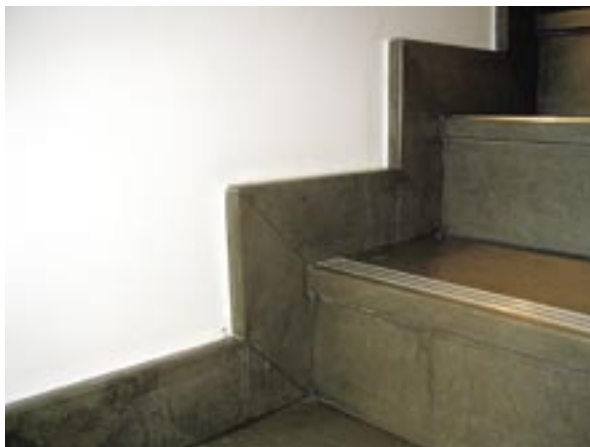
Fot. 17.7 Cokolik schodowy.
