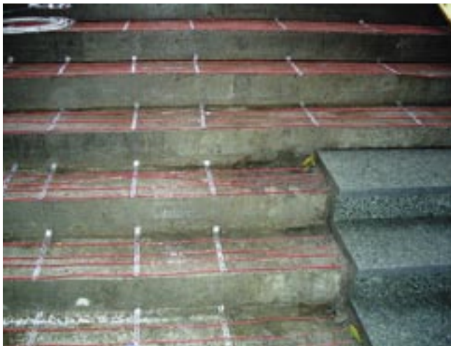
Fot. 17.10 Montaż ogrzewania elektrycznego pod kamieniem.
