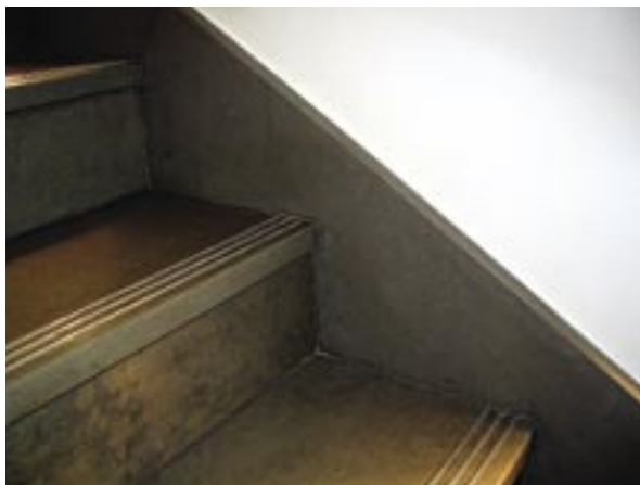
Fot. 17.8 Wangi schodowe.
