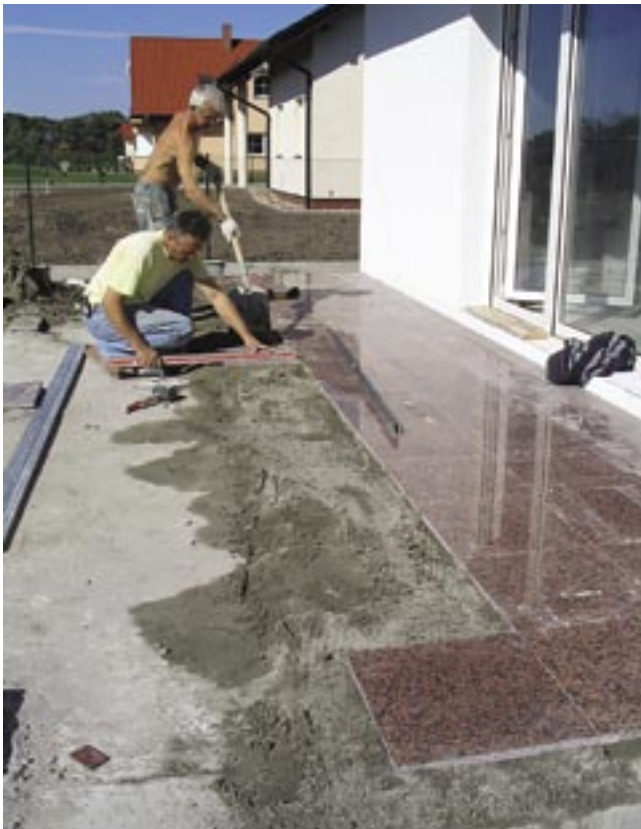
Fot. 17.3 Montaż posadzki zewnętrznej.
