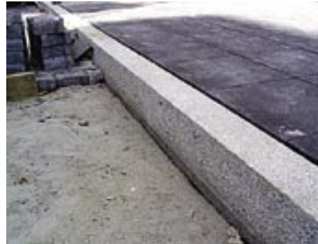
Fot. 17.4 Krawężniki przygotowane do montażu i zmontowane.
